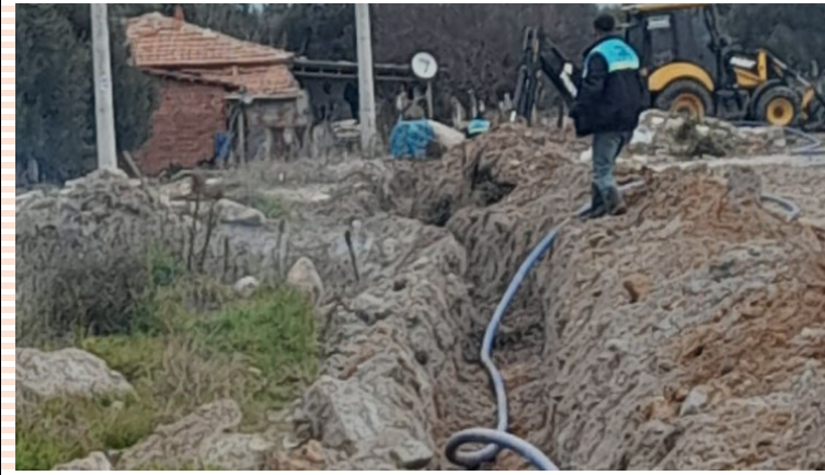
CİHANPAŞA KÖYÜ İÇMESUYU İSALE HATTI YAPIM İŞİ
