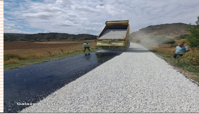
KEMALLI, BUZLUK ve YANIK 2. KAT ASFALT KAPLAMA YAPIMI
