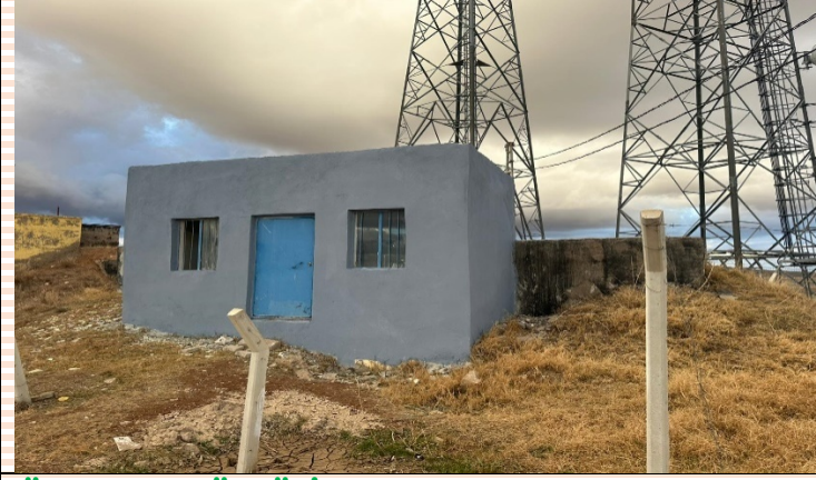
ÖZLER KÖYÜ İÇME SUYU DEPO YAPIM İŞİ
