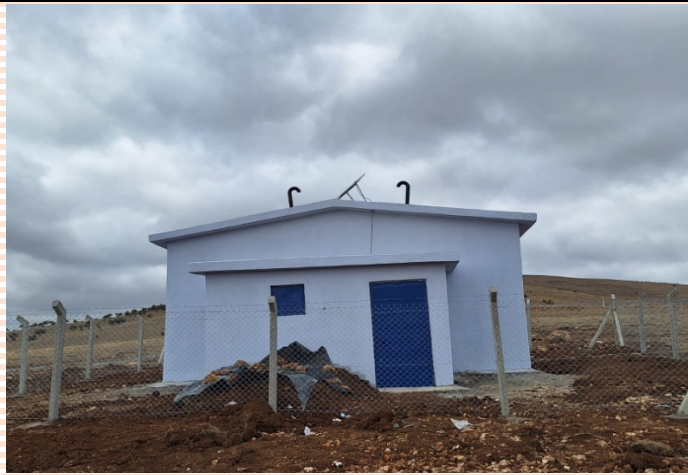
HACIÇEŞMESİ KÖYÜ İÇME SUYU DEPOSU YAPIMI
