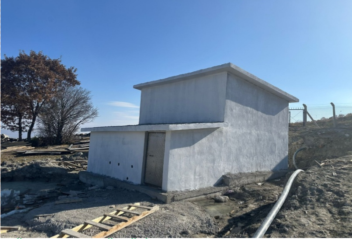
KÖRPINAR KÖYÜ İÇME SUYU DEPOSU YAPIMI
