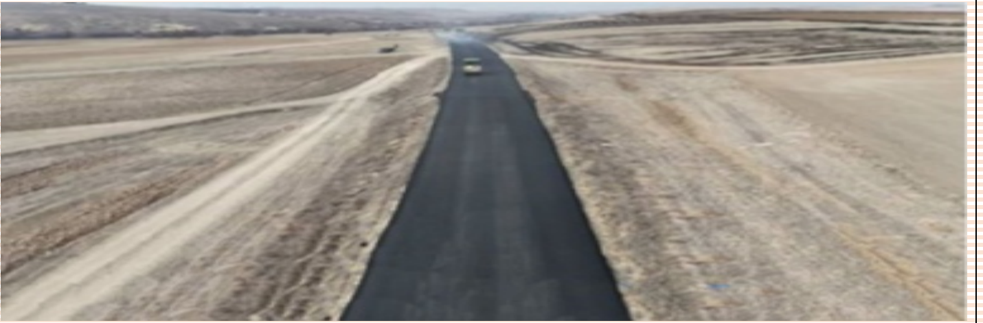
BARAKLI KÖYÜ BSK YAPIM İŞİ
