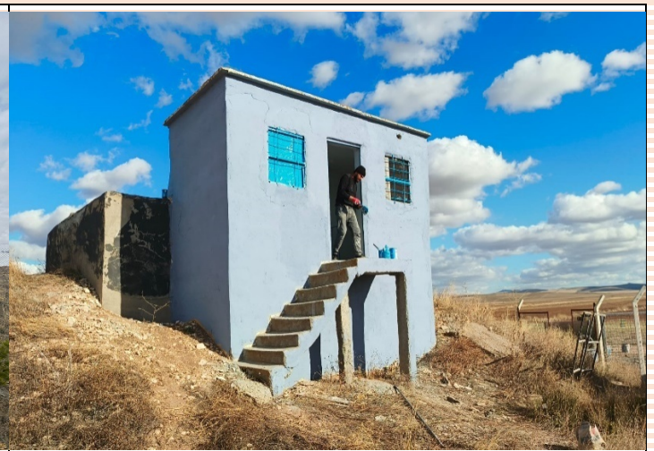
KARAKUYU KÖYÜ İÇME SUYU DEPO YAPIM İŞİ
