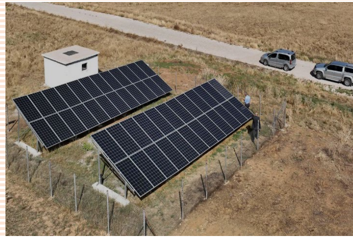
MUSABEYLİ BOĞAZI KÖYÜ İÇME SUYU GES.KURULUMU YAPIM İŞİ
