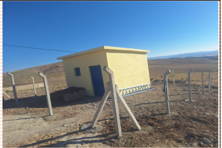
HACIOSMANLI KÖYÜ ALT BİRİKTİRME DEPOSU YAPIMI
