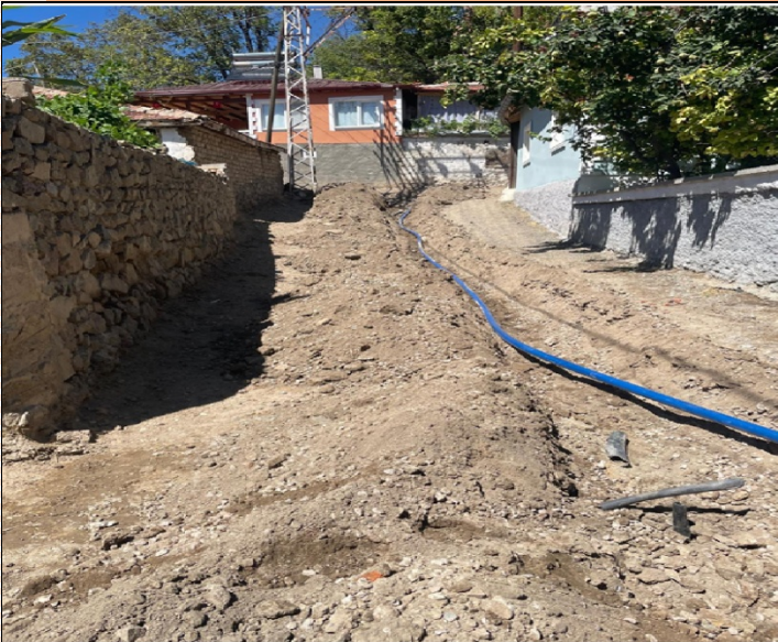
SEYDİYAR KÖYÜ İÇME SUYU HATTININ YENİLENMESİ İŞİ
