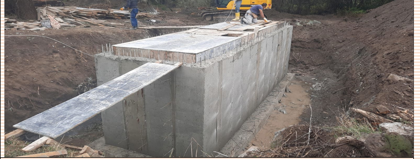
BUZLUK-ÇEPNİ BAĞLISI FOSSEPTİK ÇUKURU
