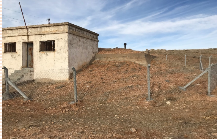
İĞDELI KÖYÜ İÇME SUYU DEPO ÇALIŞMASI
