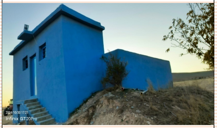
YOĞUNHİSAR KÖYÜ İÇME SUYU DEPO YAPIM İŞİ
