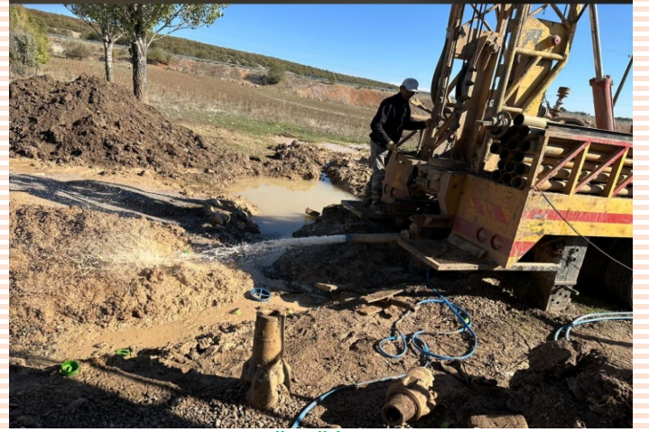
KURUÇAY KÖYÜ İÇME SUYU DEPOSU BAĞLANTI ÇALIŞMALARI
