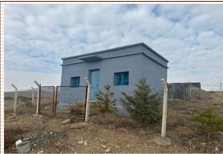
DEREÇEPNİ KÖYÜ İÇME SUYU DEPO YAPIM İŞİ
