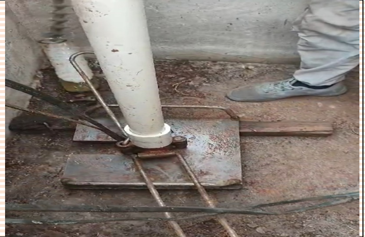
GÜLPINAR KÖYÜ İÇME SUYU SONDAJ ÇALIŞMASI
