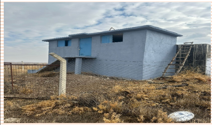
YEŞİLHİSAR KÖYÜ İÇME SUYU DEPO YAPIM İŞİ
